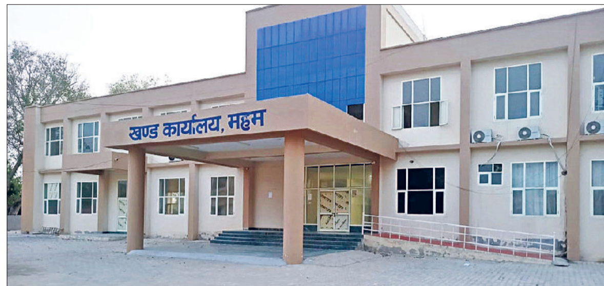
महम। खंड कार्यालय महम का भवन।
